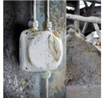
Řada KF: IP 66 / IP 67 / IP 69 odolné proti povětrnostním vlivům, pro nechráněnou venkovní instalaci metrické předlisí
